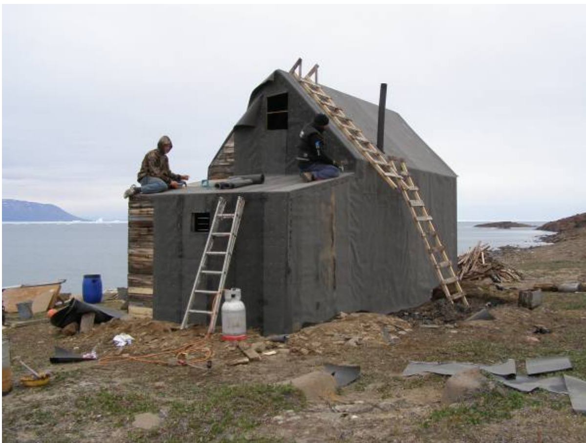
Underpappen sømmes på, et søm for hver 10 cm. Det giver ca. 10.000 papsøm!
