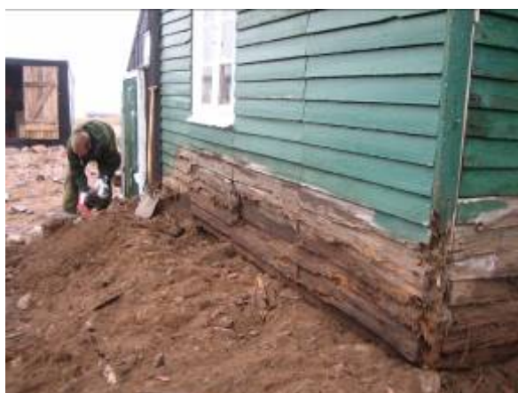
Stenmuren foran vestvæggen fjernes og der afsløres en våd og rådden væg.
