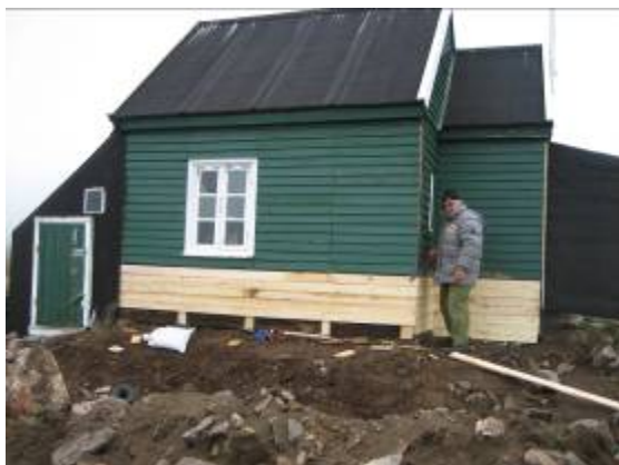
T.v.: Den underste del af den ydre bræddevæg udskiftes og forstærkes.
