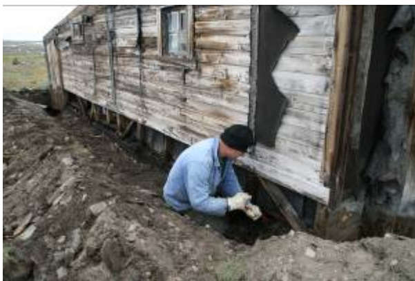
På grund af råd var det nødvendigt at udskifte de nederste brædder på for- og bagside af huset.
