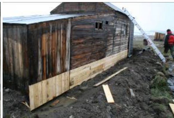
På grund af råd var det nødvendigt at udskifte de nederste brædder på for- og bagside af huset.
