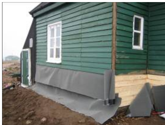
T.v.: Den underste del af den ydre bræddevæg udskiftes og forstærkes.
