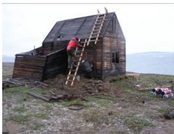
Laplace var ved ankomsten åben og gennemfugtig, men efter 12 timer med munden fyldt med papsøm under uafbrudt papning var opholdsrummet ryddet op og tæt.
